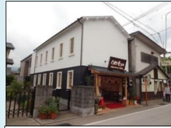
景観形成に対応した 店舗ファサード改修
