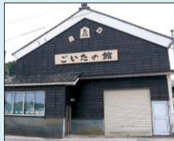
伝統芸能伝承の為の施設改修
